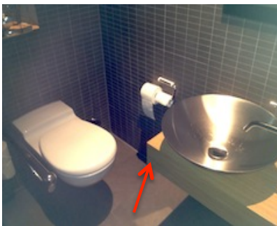
Bild 19 L-Griff fehlt. Waschbecken „Design-Produkt“, schön rund, Tischblatt leider zu eckig!
