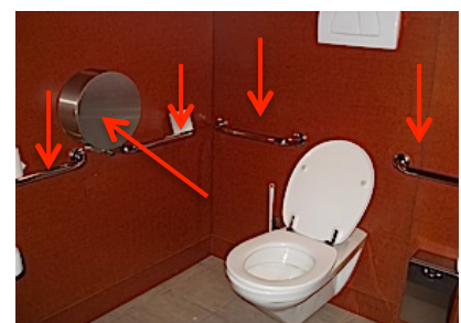
Bild 15 Vier, ab dem Klo unerreichbare Haltegriffe. Do. Papierrolle.
