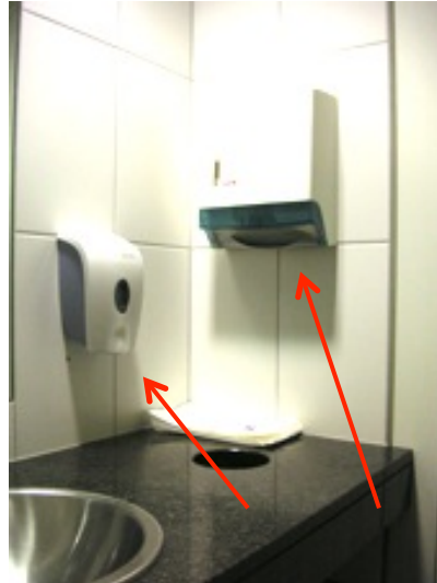
Bild 17 Seifen- und Papierspender vom Rollstuhl aus nicht ergreifbar!.
