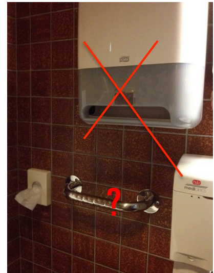
Bild 9 Kein L-Haltegriff. Handtuchspender störend über Haltegriff und zu hoch ab Boden.
