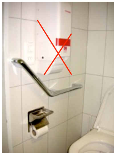
Bild 11 Kein L-Haltegriff (vgl. Bild 6). Ungünstige, störende Lage Papierspender über Handgriff.
