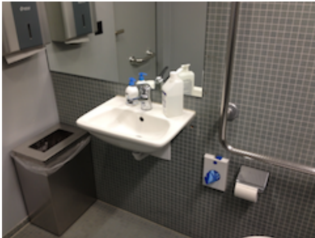
Bild 4 Waschbecken unterfahrbar, - die Front dürfte etwas abgerundeter sein.
