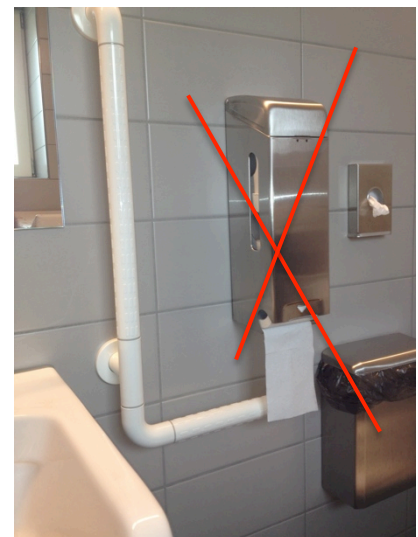
Bild 12 Ungünstige, störende Lage Papierspender über dem L-Griff.
