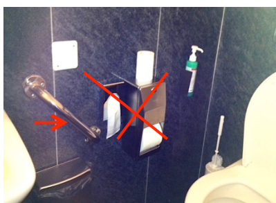
Bild 13 Ungeeigneter Schräggriff, störende Lage Papierspender.
