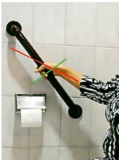
Bild 10 „Schräggriff“ vermeiden! Abgleitgefahr und ungünstige Beanspruchung des Handgelenkes.
