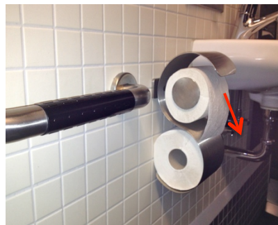
Bild 20 „Design-Produkt“. Unpraktisch. - rollt ohne zu bremsen ab!
