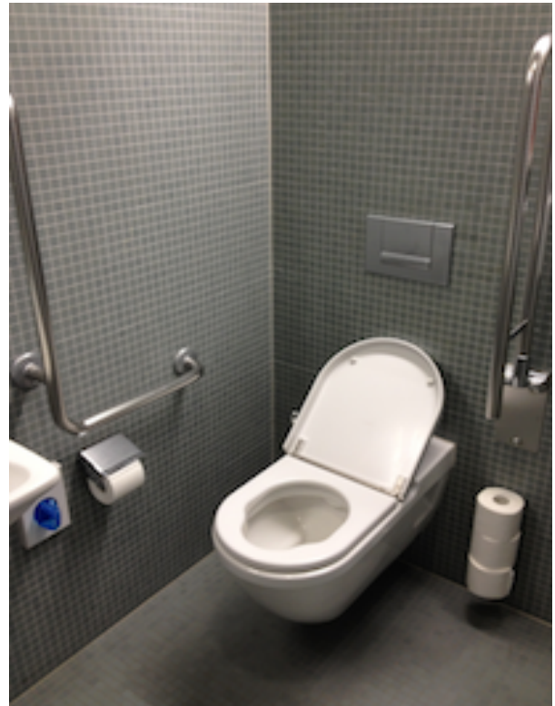
Bild 6 Korrekt ausgeführt: L-förmiger Haltegriff, darunter Paierhalter, rechts einhändig bedienbarer Stützklappgriff. Option „Rückenstütze“ nicht ausgeführt.
