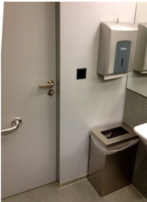
Bild 5 Abfallbehälter evtl. unterfahrbar. Türe nach aussen öffnend, - innen mit korrektem Zuziehgriff.
